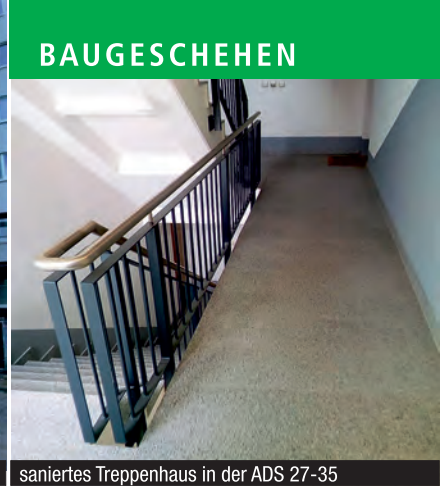
saniertes Treppenhaus in der ADS 27-35
