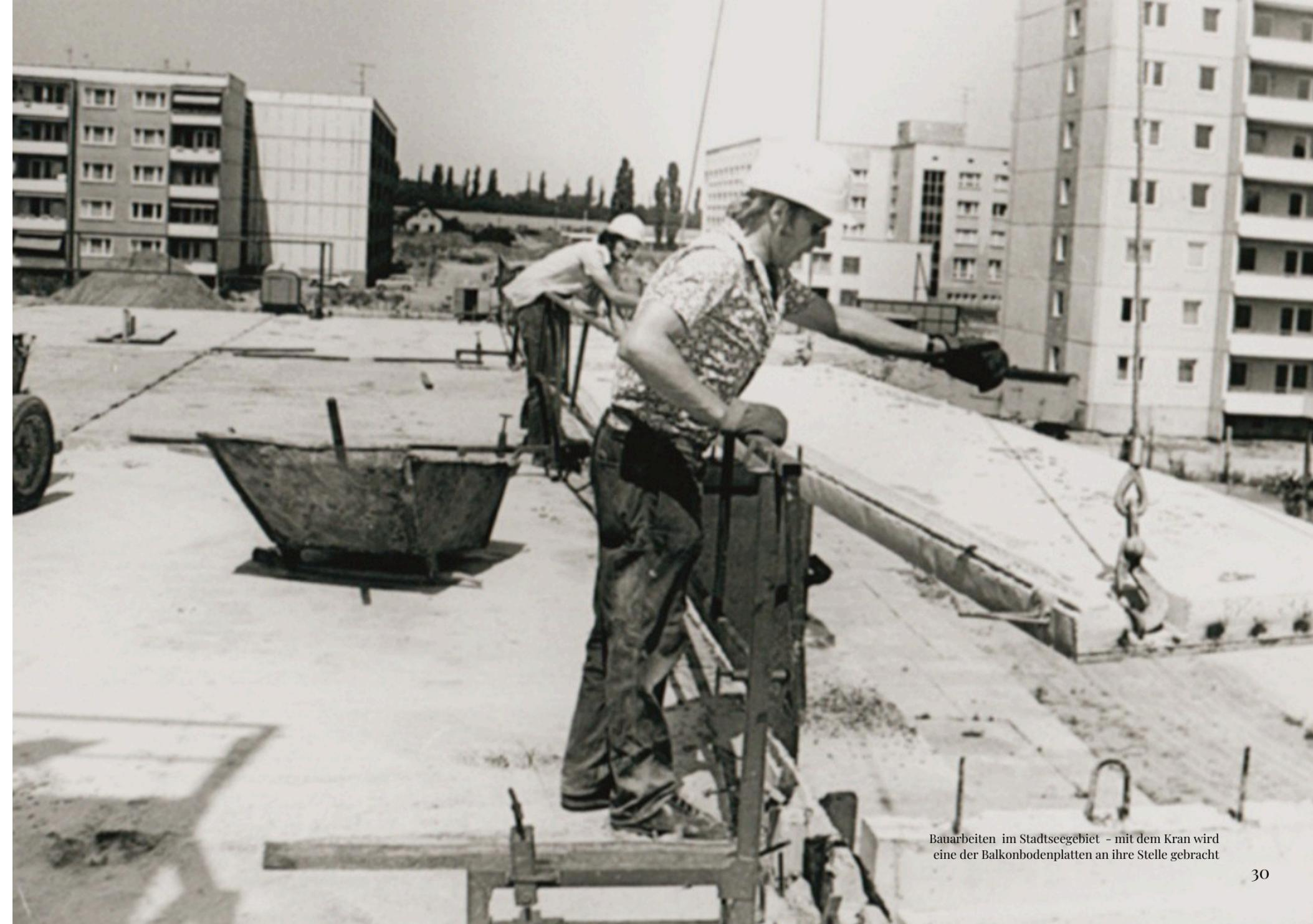
Bauarbeiten im Stadtseegebiet - mit dem Kran wird eine der Balkonbodenplatten an ihre Stelle gebracht
